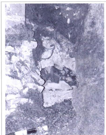
Cliché 38 : gaine dans la tour du château.
