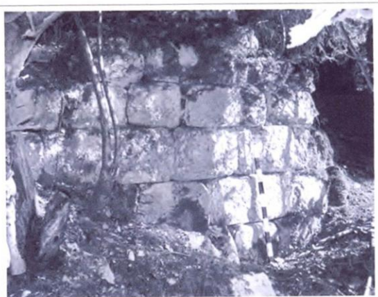
Cliché 59 : enceinte sud du château.
