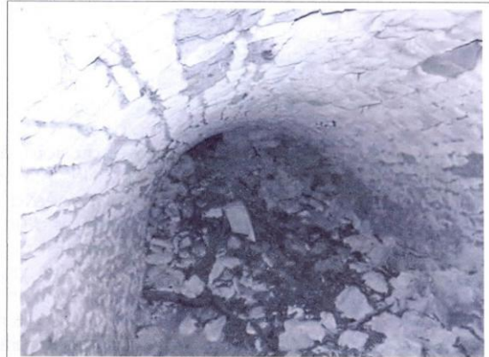
Cliché 47 : salle voûtée dans le fossé sud-est.
