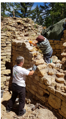
Étanchéification des murs
