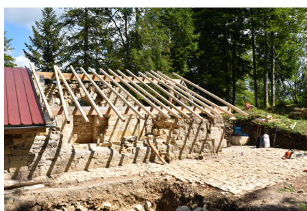
Construction de toitures
