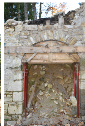
Reconstruction d'une voûte de porte
